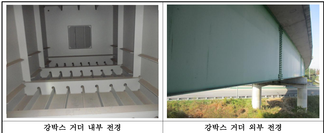
【사진 3.5】 강박스 거더 전경
