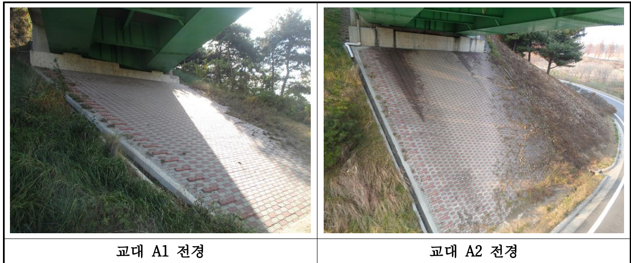
【사진 3.11】 교대 전경
