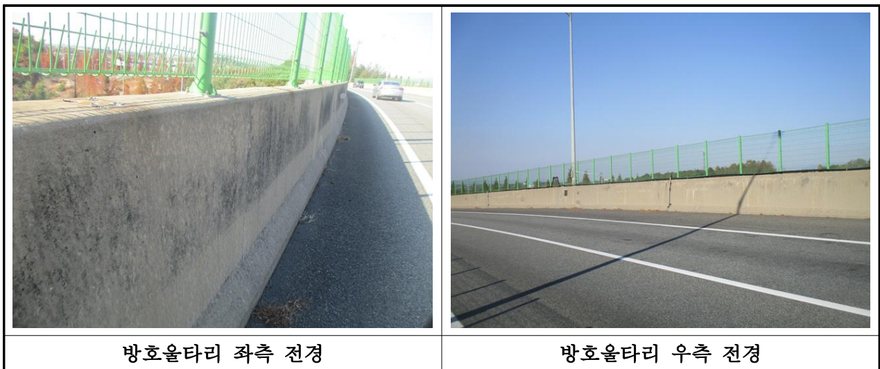
【사진 3.24】 난간 및 연석 전경
