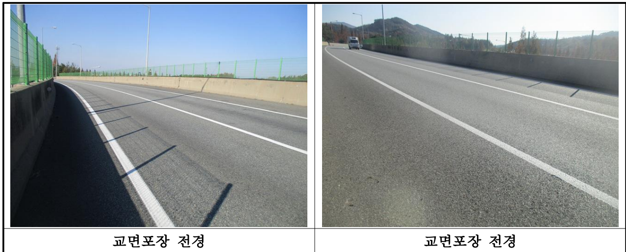
【사진 3.20】 교면포장 전경
